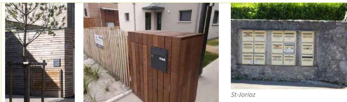
Image 44 - Intégration des éléments techniques dans la clôture
